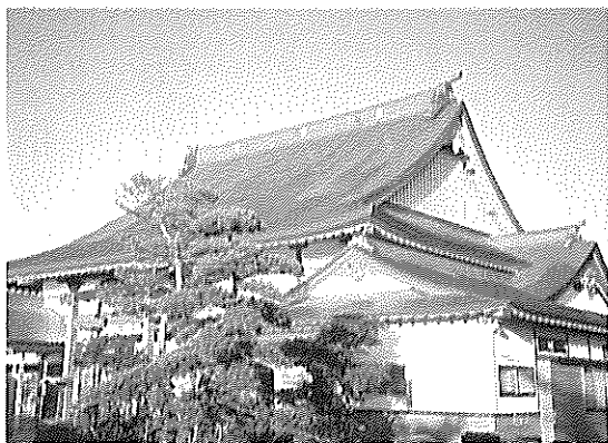
㊦平成13年大改修工事を行い、一新した順覚寺の本堂。
